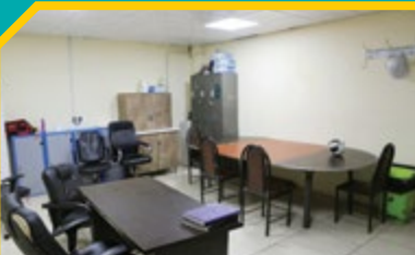
ساخت اتاق پرسنل کارخانه فولادسازی
