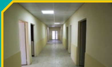
تعمیر ساختمان مدیریت ارشد فولادسازی
