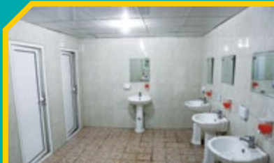
تعمیر سرویس بهداشتی ورودی رستوران فولادسازی
