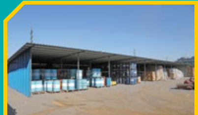
انبار مسقف فلزی احیاء
