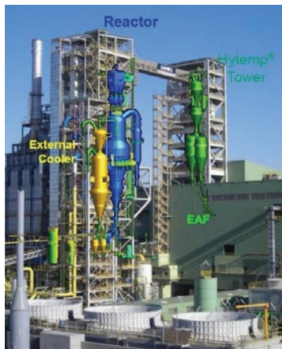
شکل ۶. فرآیند انتقال HDRI به روش Hytemp در کارخانه فولاد امارات
